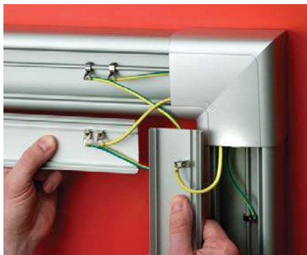
Количество монтируемых проводов заземления в плоском угле
