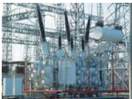
Электрические сети Электростанции, подстанции, линии электропередач
