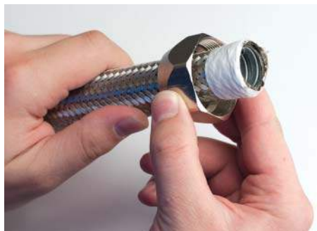
1. Вначале следует надеть на металлорукав зажимную гайку
