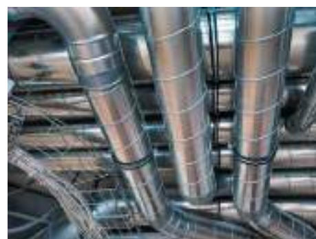
Системы вентиляции, кондиционирования и трубопроводы
