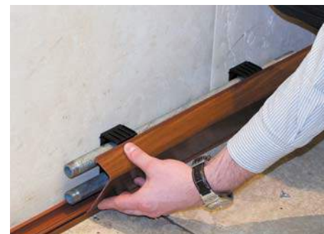
Система закрывается декоративной крышкой
