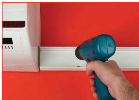
Закрепите основание короба на стене
