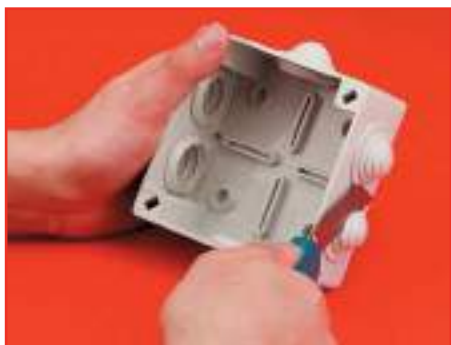
Срезаем кабельный ввод
