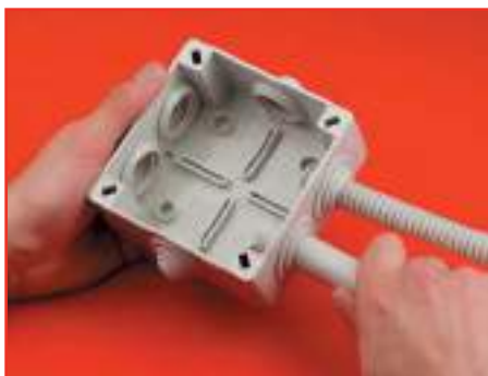
Заводим гофрированную и жесткую трубы
