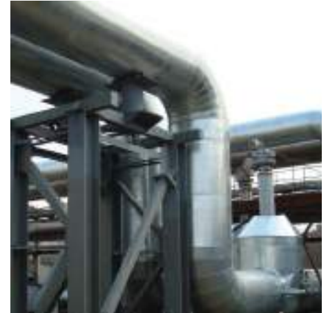
Системы вентиляции, кондиционирования и трубопроводы
